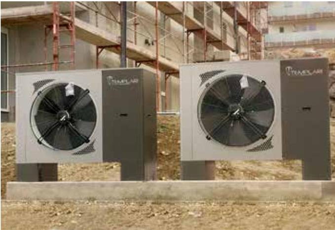
Normalmente nelle macchine commerciali vengono utilizzati ventilatori con motori asincroni, viene impiegata la tecnica del taglio di fase per modularne la velocità. Questo sistema presenta problematiche nella resa e nel comfort perché si viene a generare un fastidioso ronzio alle basse velocità e i consumi elettrici rimangono elevati anche quando il motore gira piano. È molto utilizzata poiché la più economica come componentistica.
