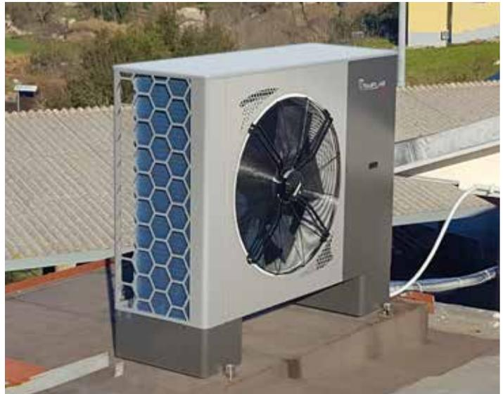
Per isolare il rumore generato dal compressore, viene utilizzato un **cappotto acustico** specifico per il componente, tutte le carpenterie che contengono gli organi del circuito frigorifero sono state isolate con appositi pannelli isolanti ritagliati su misura e impiegati sia per le pareti sia per la lamiera inferiore che superiore.
