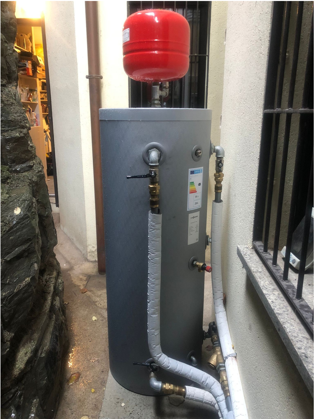
Fig. 52: Accumulo acs e relativo vaso di espansione
